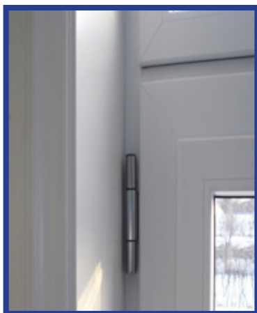
naar binnen draaiende deur met 3-voudig verzonken scharnieren
