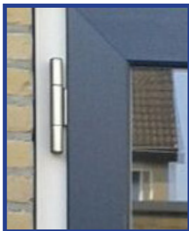
naar buiten draaiende deur met 3-voudig verzonken scharnieren
